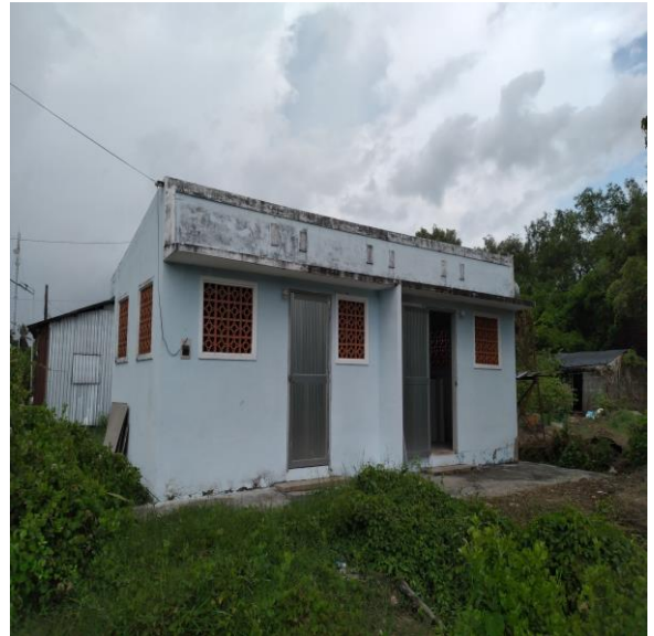
Khu nhà vệ sinh
